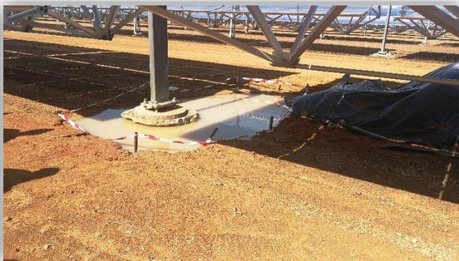
**Ilustración 5.** Foto de una fuga de contaminante ocurrido en una planta termosolar de Extremadura.
